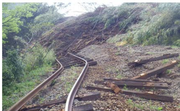
熊本地震により甚大な被害が生じた立野駅付近
